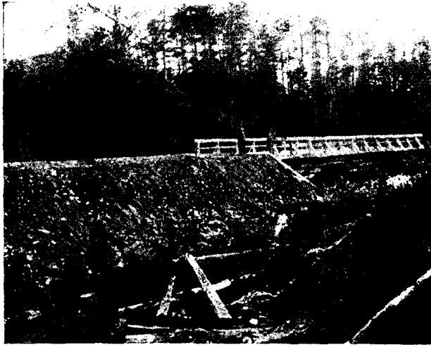
Фиг. 24. Устройство насыпи при подходе к мосту (Николаевская магистраль).
