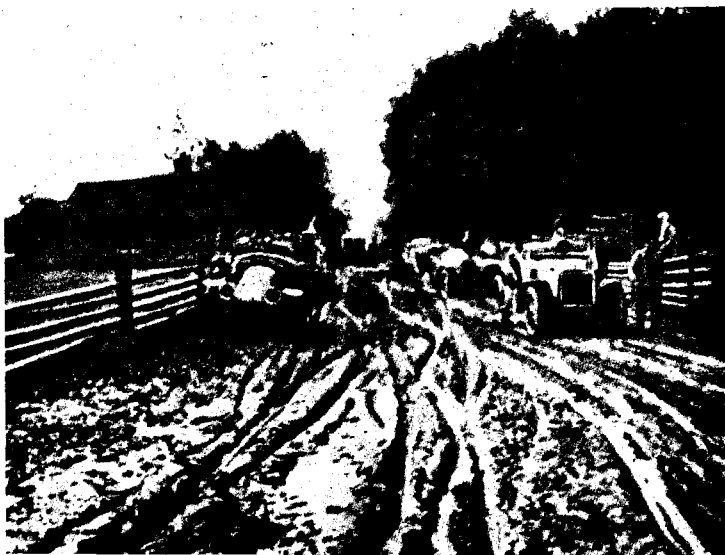
Фиг. 21. Состояние неуллучшенной грунтовой дороги после дождей.
