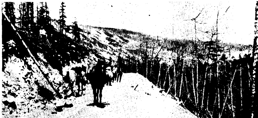
Фиг. 22. Устройство полотна на косогоре (Николаевская магистраль в Дальневосточной области).
