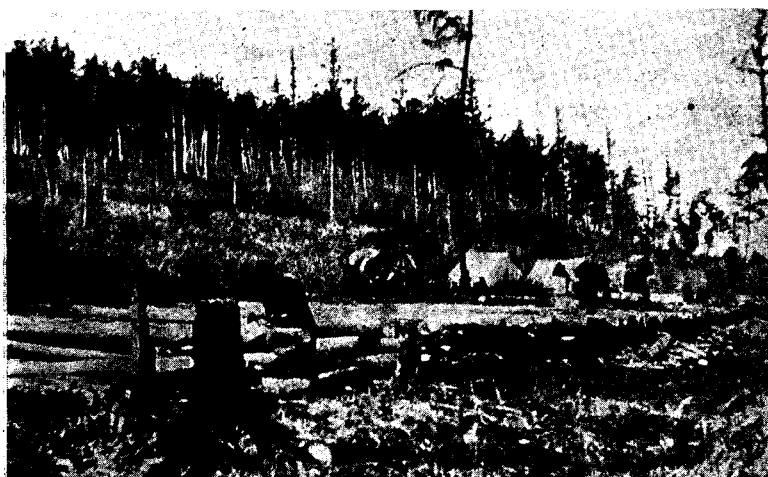
Фиг. 26. Устройство бревенчатой гати (временка Амурской жел. дороги).
