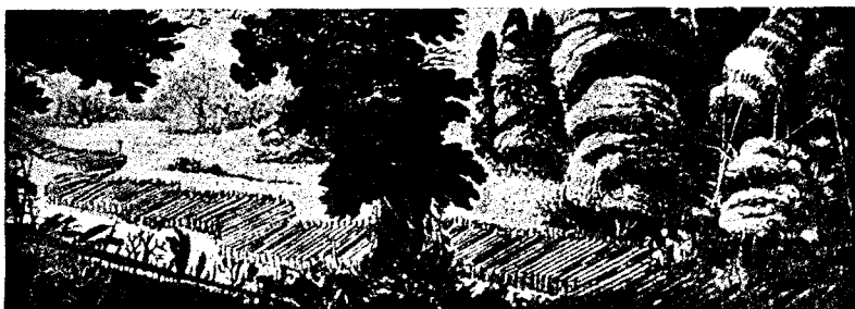
Фиг. 53. Постройка дороги между Петербургом и Москвой (1720—1746).
