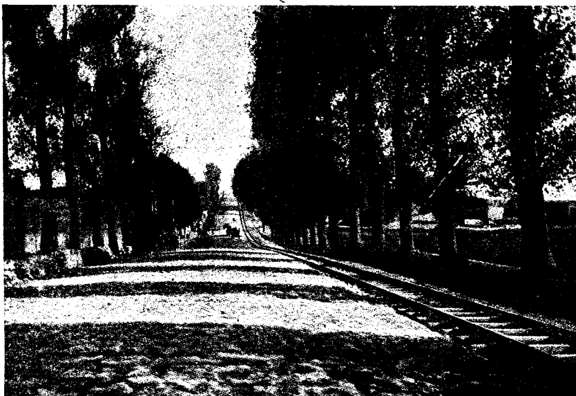
Фиг. 84. Укладка трамвайного пути на мощеной дороге Лодзь — Згерж.
