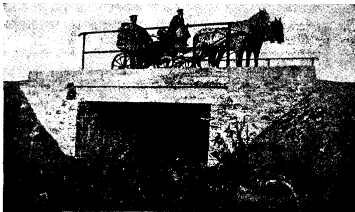
Фиг. 65. Жел.-бетонный земский мост.
