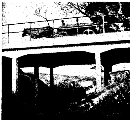
Фиг. 65а. Земский жел.-бетонный мост безустойного типа. (Таращанский уезд Киевской губ.)
