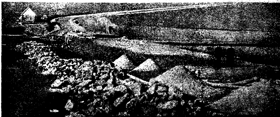
Фиг. 120. Изгиб дороги при спуске в долину. (Постройка земского шоссе в Тульской губ.)
